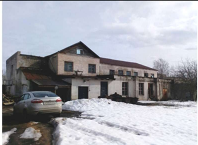
Здание производственного корпуса (Лит. В)
